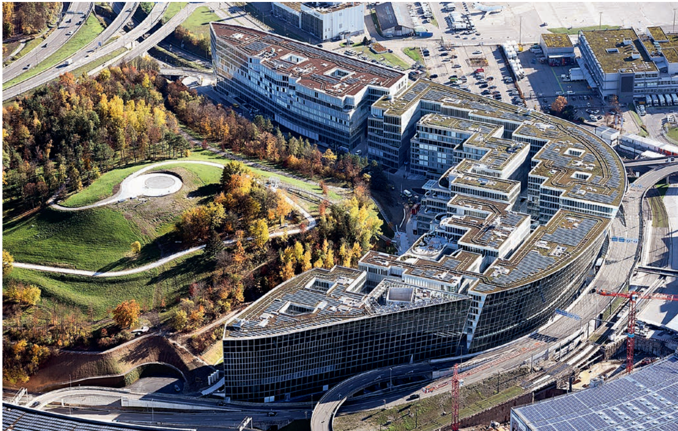
Seinerzeit die grösste Hochbaustelle der Schweiz: The Circle mit dem Butzenbuel-Hügel im Rücken. (Bild: The Circle)
