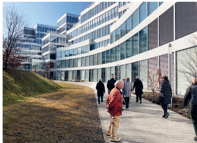
Ein Gebäudekomplex mit zwei Gesichtern: von vorn eine gläserne Steilwand, von hinten ein gestaffeltes Ensemble von Kuben. (Bild: P. Rüttsche) (Bild: P. Rüttsche)
